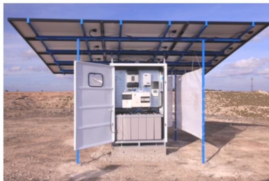
Пиковая мощность устройства составляет 3,4 кВт, номинал выхода переменного тока 3 500 ВА, что в общем дает производительность в 7 900 Вт\*ч в день. Устройство может обеспечить энергопитанием до 25 домов в течение пяти часов в сутки три дня подряд.
