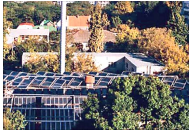
Рис. 4. Солнечно-топливная котельная в г. Анапе Краснодарского края Fig. 4. Solar-heat boiler room in Anapa, Krasnodar region
